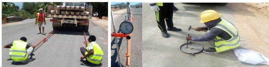
Figure 1: Appareils de mise en œuvre.
