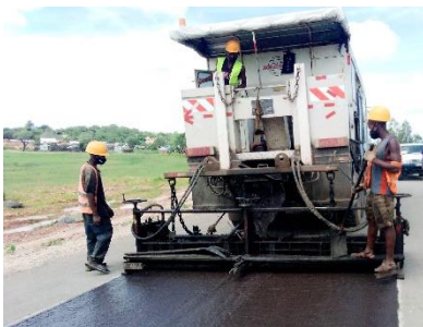
Figure 9 : Mise en œuvre couche scellement au 23+200.
