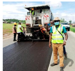
Figure 9 : Mise en œuvre couche scellement au 23+200.
