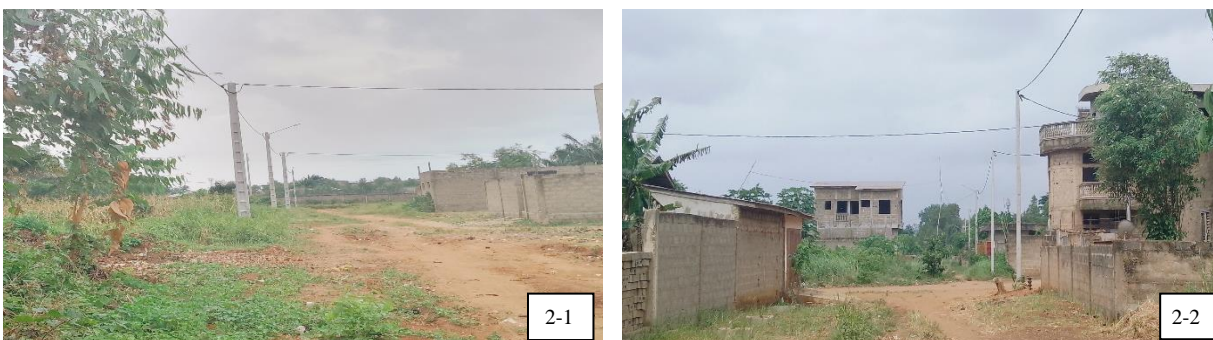
Figure 11 : Extension du réseau électrique dans la commune d'Adjarra. (Prise de vues : M. A. N. A. Hessou, Août 2024).
