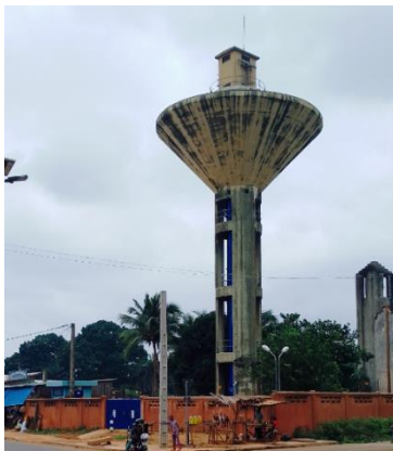
Figure 10 : Château d'eau de la commune d'Adjarra. (Prise de vue : M. A. N. A. Hessou, Août 2024).
