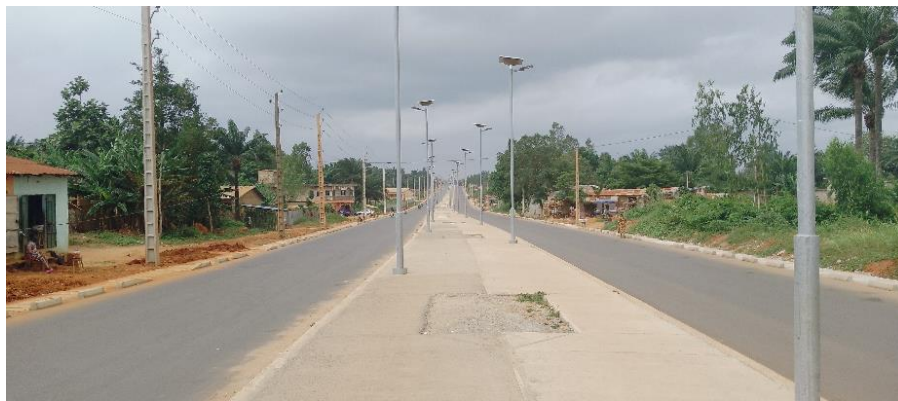
Figure 12 : Aperçu des travaux d'aménagement routier dans la commune d'Adjarra. (Prise de vue : M. A. N. A. Hessou, Août 2024).
