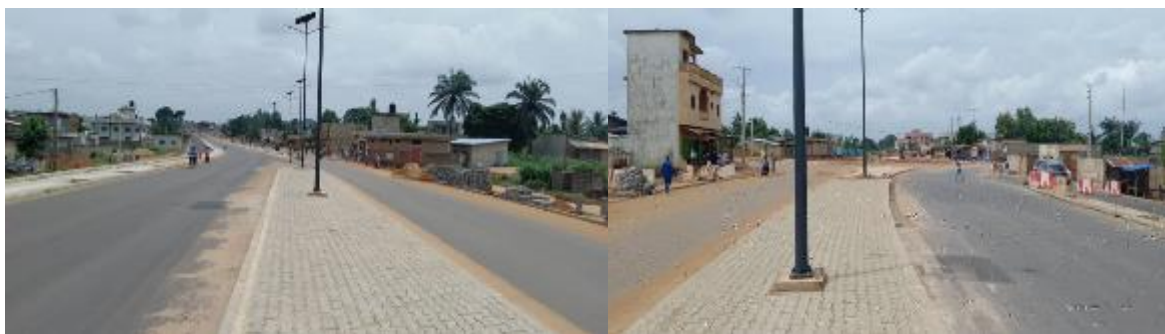
Figure 2 : Aperçu des travaux d'aménagement routier dans la commune d'Adjarra. (Prise de vues : M. A. N. A. Hessou, septembre 2024)
