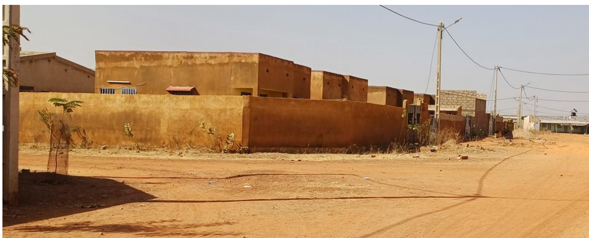
Figure 11 : Logements sociaux de type F3 inoccupés dans la cité des forces vives de Tenkodogo (Cliché : SAWADOGO M., janvier 2024).
