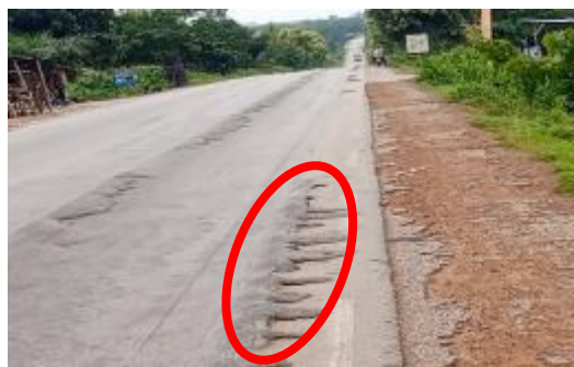
Figure 12 : Ornière accompagnée de bourrelet sur la RNIE 2 à hauteur de Pauignan. (Prise de vues : Hessou, mars 2022).
