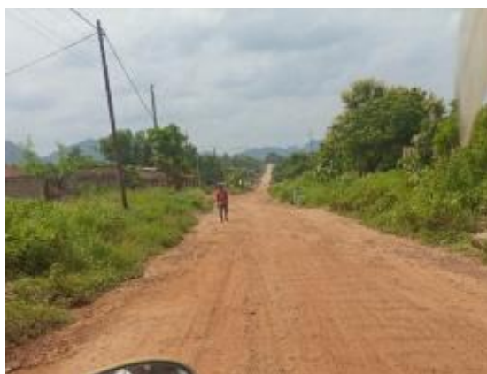
Figure 17 : Piste en tôle ondulée dans la commune de Glazoué (Prise de vue : Hessou, mars 2022).
