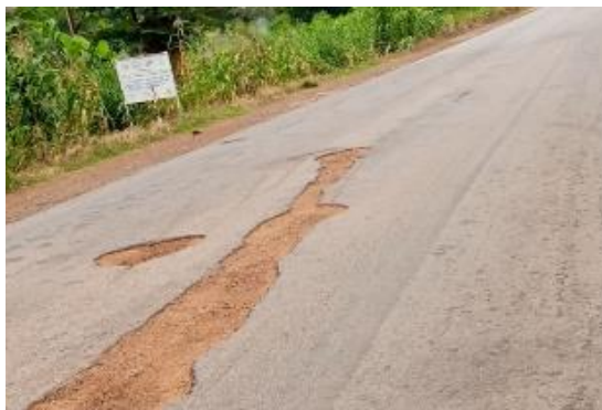
Figure 10 : Pelade sur l'axe Dassa-Pauignan dans la commune de Dassa-Zoumè (Prise de vue : Hessou, mars 2022).
