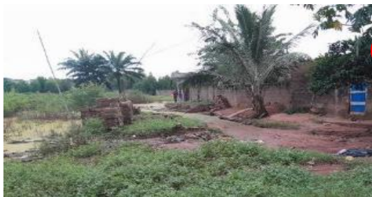
Figure 5 : Occupation d'une zone inondable par les habitations à Honvié
