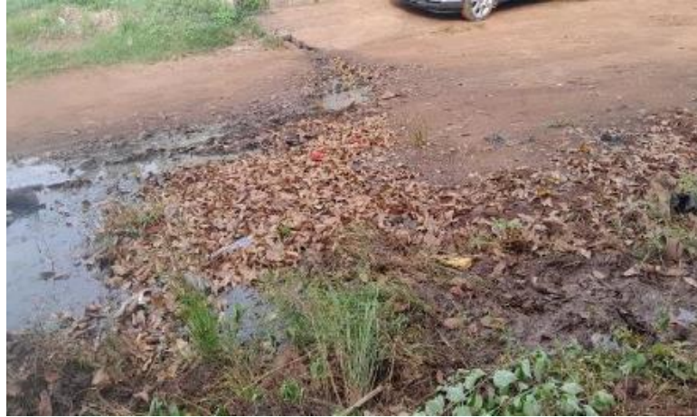
Figure 11 : Evacuation d'eau usée sur la voie publique à Hêvié-Kpota (arrondissement de Malanhoui). (Prise de vue : C. Kiki, septembre 2023).
