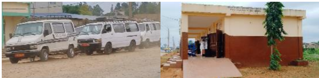
Figure 7 : Aperçu d'une gare routière provisoire et d'une boutique réalisée dans la commune d'Adjarra (Prises de vues : M. A. N. A. Hessou, septembre 2024).
