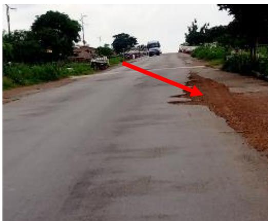
**Figure 9 :** Epaufrure au niveau de Gankpètè dans l'arrondissement de Tré. (Prise de vue : Hessou, mars 2022)
