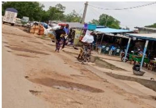
**Figure 7 :** Nids de poules sur une chaussée de la RNIE 2 dans l'arrondissement de Dassa I. (Prise de vues : Hessou, mars 2022).
