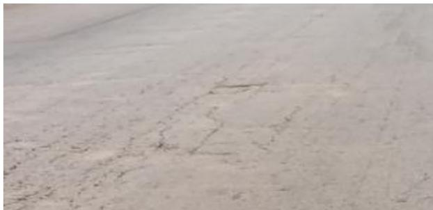
**Figure 15 :** Fissure longitudinale sur une l'axe Togon dans Dassa-Zoumè. (Prise de vues : Hessou, mars 2022).
