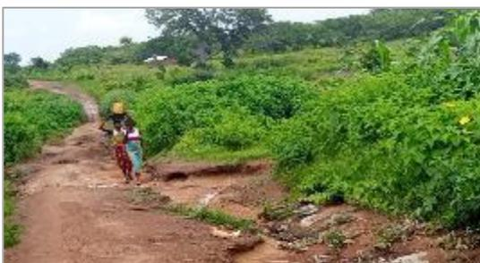
**Figure 18 :** Piste détruite par l'érosion pluviale à Ouèdèmè. (Prise de vues : Hessou, mars 2022).
