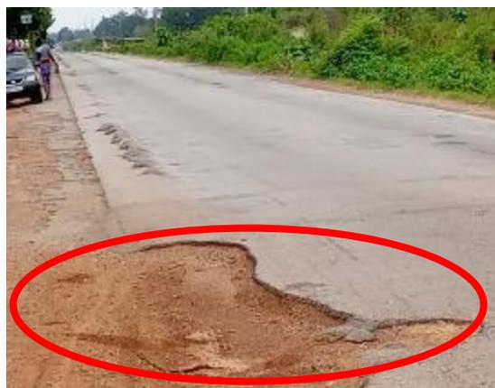
**Figure 8 :** Epaufrure au niveau de Gbowèlè dans la l'arrondissement Paouignan. (Prise de vue : Hessou, mars 2022).
