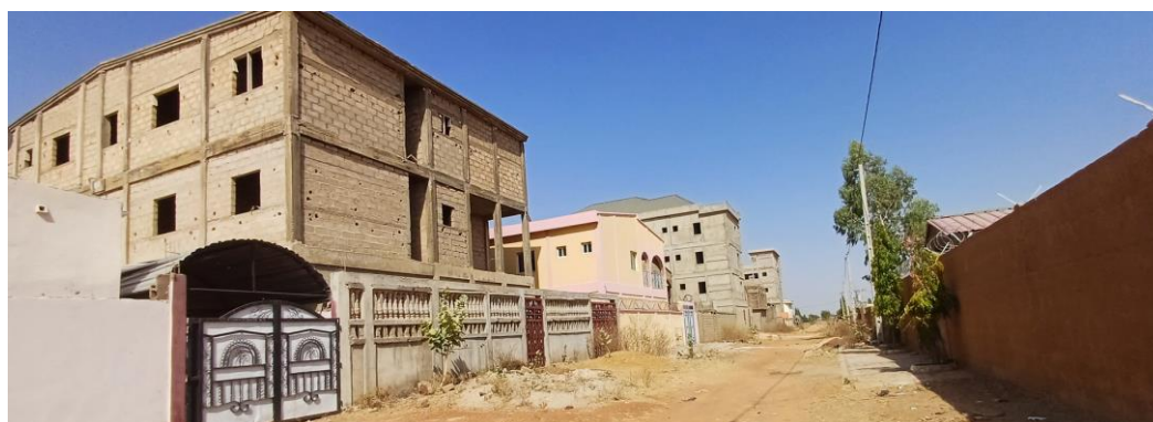
Figure 4 : Vue d'une rue dans la cité des forces vives de Tenkodogo avec des logements de haut standing en cours de construction (Cliché : SAWADOGO M., janvier 2024).
