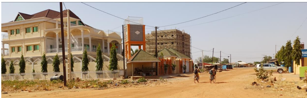
Figure 10 : Logements de standing élevé en auto-construction dans la cité des forces vives de Tenkodogo (Cliché : SAWADOGO M., janvier 2024).
