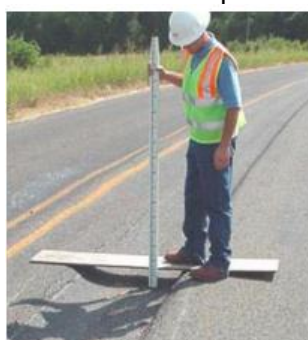
Figure 1 : Illustration de l'orniérage d'une chaussée (Ali, B. 2006).
